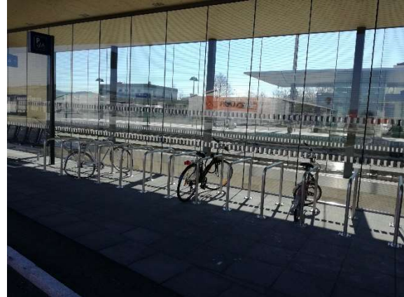
Bhf. Mattersburg – Neue Abstellanlage an der Ostseite
