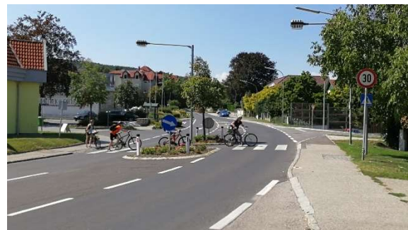
30 km/h-Beschränkung Mattersburgerstraße im Ortszentrum Bad Sauerbrunn
