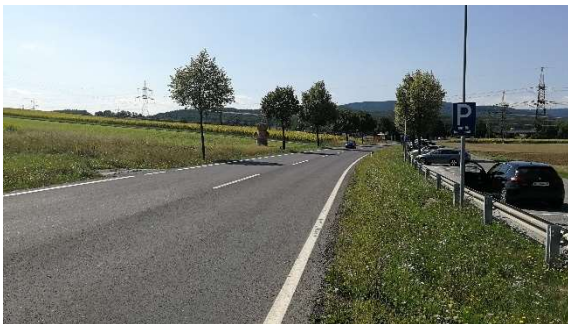
Nicht für Radverkehr geeigneter Abschnitt der Forchtensteinerstraße zwischen Mattersburg und Forchtenstein
