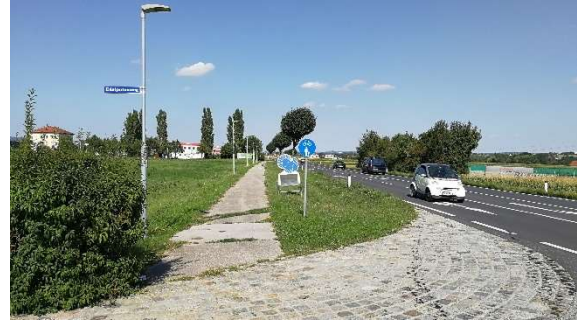
Bestehender Geh- und Radweg bei Gewerbegebiet Pöttelsdorf
