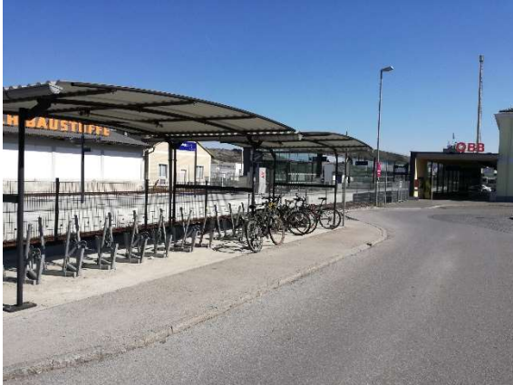
Bhf. Mattersburg – Ältere Abstellanlage an der Westseite
