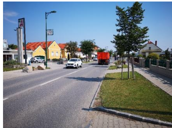
Nicht radfahrtauglicher Abschnitt an der B50 zwischen Bahnbrücke und Kreisverkehr
