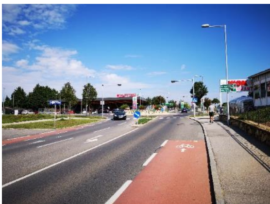
Mehrzweckstreifen B50 – Wiener Straße mit Unterbrechung beim Kreisverkehr
