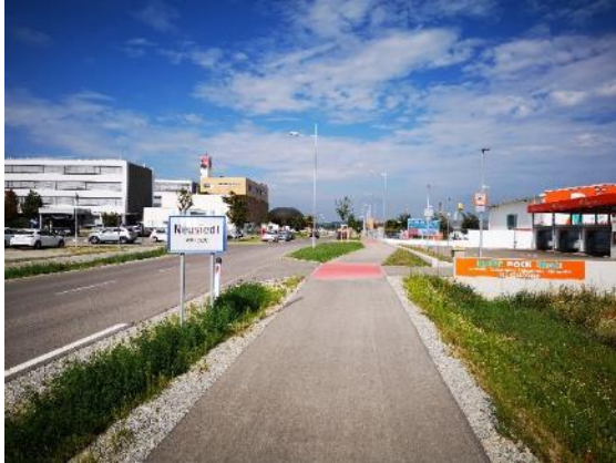
Neue Radwegeverbindung im Betriebsgebiet Prädium
