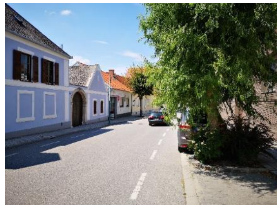
Jois: problematische Breite des markierten Mehrzweckstreifens (insbesondere entlang Längsparker)
