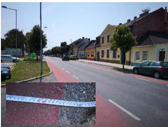
Mehrzweckstreifen B51 – Untere Hauptstraße mit teilweise unzureichender Breite
