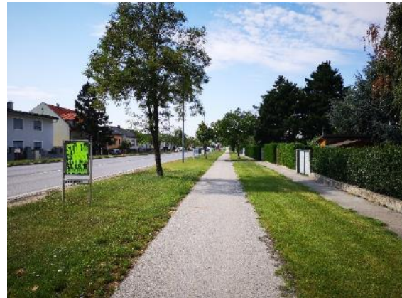
Radweg entlang B50 (Hirschfeldspitz stadteinwärts)
