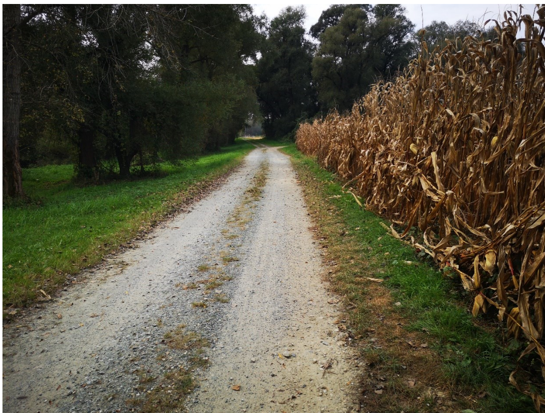
Varianten B: Belagsverbesserung notwendig auf dem Weg zwischen Ledererstraße und Furt
