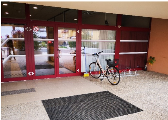
Wenig geeignete Abstellmöglichkeit beim BORG Jennersdorf. Positiv: unter Dach und direkt beim Eingang
