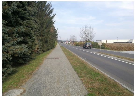
Radweg entlang der B57 – nördlich der Straße mit Querungsnotwendigkeit zu den Handelsbetrieben
