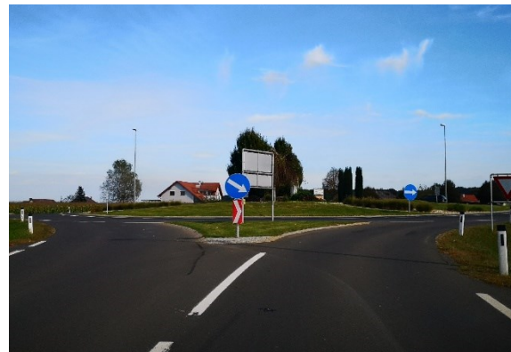
Kreisverkehr zwischen Doiber und St. Martin - zumindest subjektives Sicherheitsproblem
