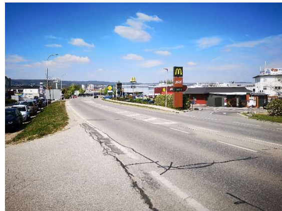
Abschnitt ohne Radinfrastruktur in der B52 Ruster Straße
