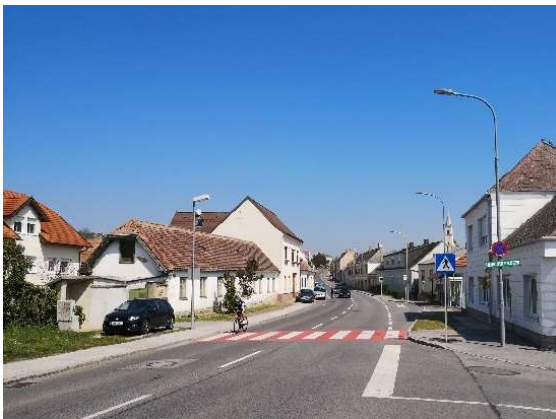
Fehlende Radinfrastruktur an der B59 in Kleinhöflein
