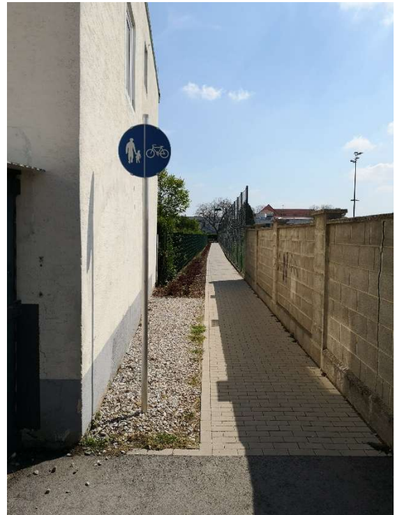
Kombinierter Geh-/Radweg zwischen Freibad und Sportplatz/Schulen in beengten Platzverhältnissen (ohne Möglichkeit zur Einhaltung von Mindestbreiten)
