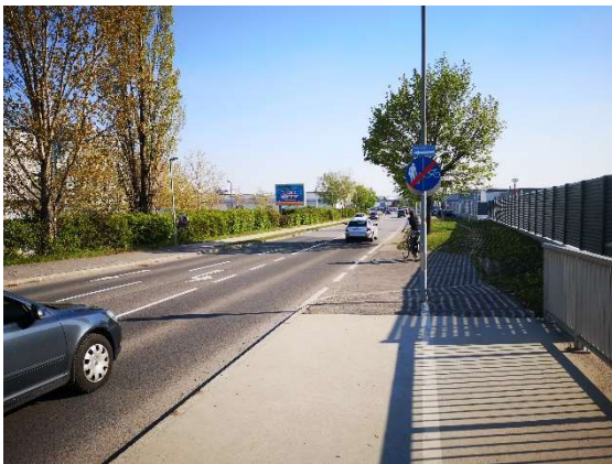
B52 Ruster Straße – keine durchgehende Radinfrastruktur
