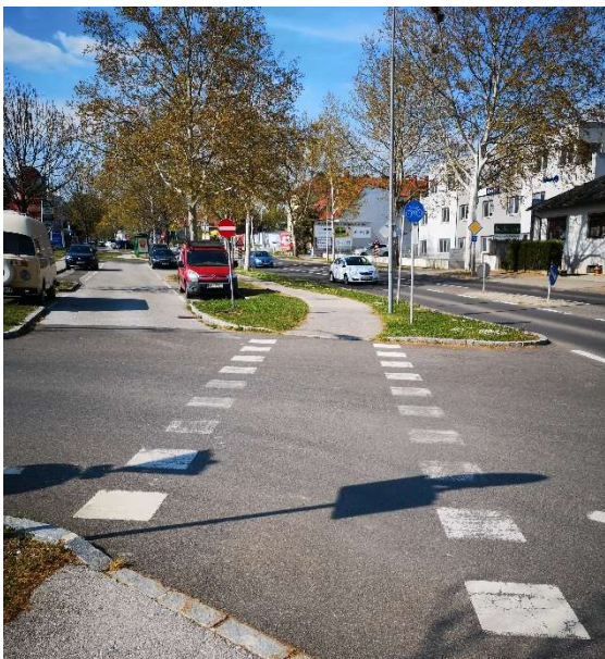
Positiv: Getrennter Radweg mit Radüberfahrten im mittleren Bereich der Ruster Straße
