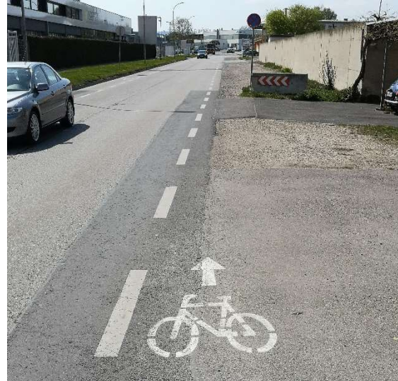
Problematisch: Mehrzweckstreifen Industriestraße
